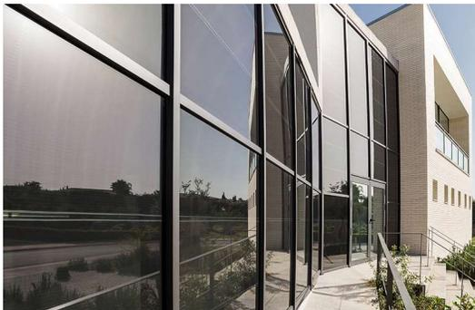
Figura 15: Muro cortina acristalado [25]
