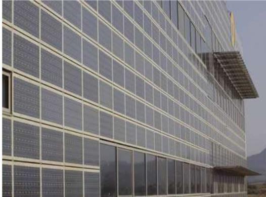
Figura 15: Muro cortina acristalado con parasoles fotovoltaicos [25]
