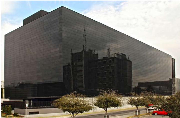
Figura 17: Fachada ventilada fotovoltaica de FEMSA Coca Cola en Monterrey [25]
